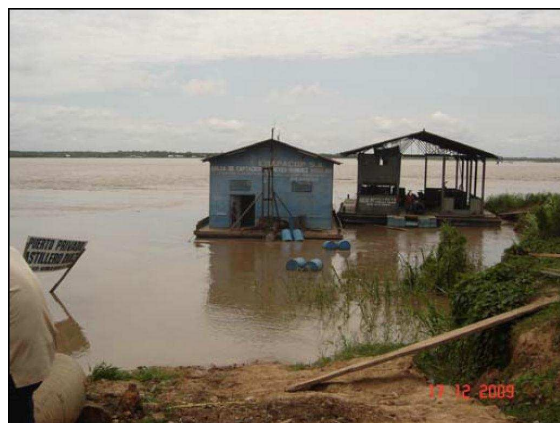
Foto N°01 Captación Balsa Robalino y Pucalpilllo
