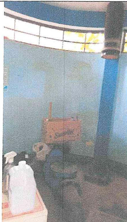
Descripción: Falta un tramo de la tubería de ventilación de la cámara húmeda.
